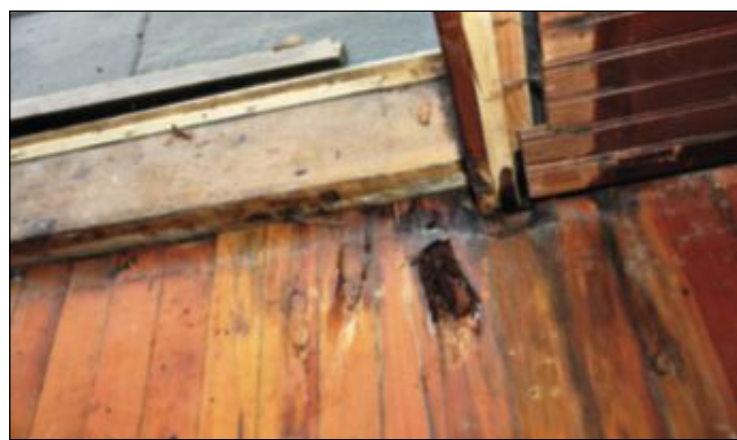
VASSKADE: Det har vore kjent sidan i vår at golvet er vasskada ved dørkarmen, men hussoppen vart oppdaga nyleg.
