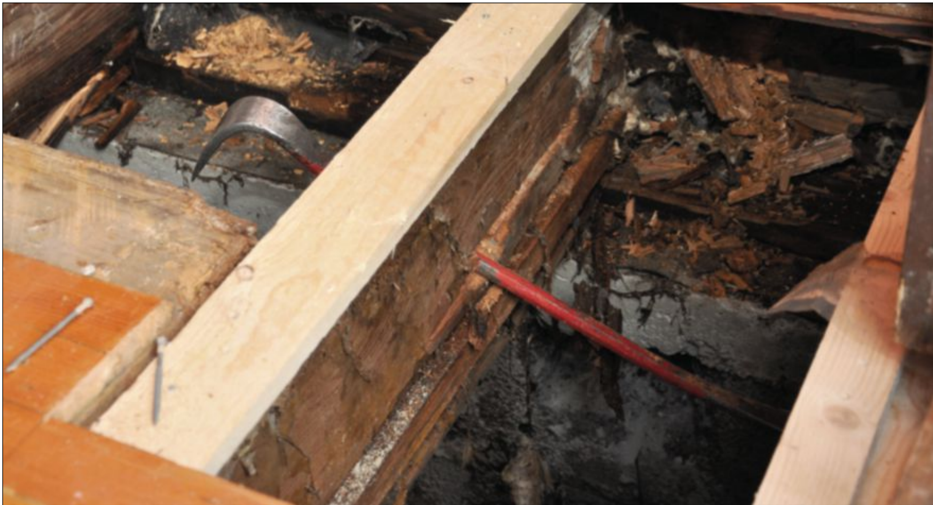
MÅ SKIFTAST: Det er lite motstand når Stein Ove Natland frå ISS plasserer kubeinet på tvers i ein av bjelkane under golvet i våpenhuset på Emigrantkyrkja.
