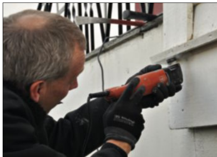
JAKTAR PÅ LEKKASJE: Stein Ove Natland frå ISS soppsanering losnar det nedste bordet av våpenhusveggen i jakta på kvar vatnet har kome seg inn. Svaret kjem i løpet av veka.
