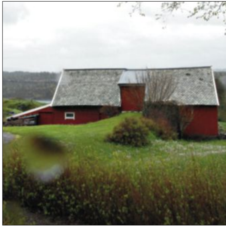
AMERIKA-STIL MED HEIM: Denne løa var den første på Sletta med låvebru i amerikansk stil. Nils Sletten reiste til Colorado på skogsarbeid i 1904. Etter fire år, kunne han reisa heim til farsgarden på Nespe på Søre Sletten. Her bygde han nytt våningshus i 1910 og ny løe i 1911.
